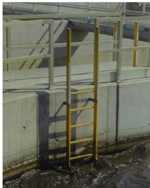
Echelle d'accès avec appui fixe MG13
