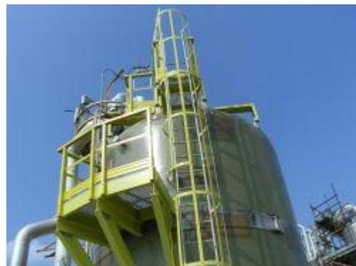
Ces échelles résistent à la corrosion et ne nécessitent aucun entretien. Dans le cas d'échelles destinées à des environnements très agressifs ou à hautes exigences contre le feu, les matériaux de base peuvent être adaptés.
