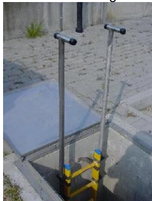
Toegangsladder met instapstijlen type MG14 /Toegangsladder met vaste instap MG13
