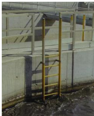
Toegangsladder met instapstijlen type MG14 /Toegangsladder met vaste instap MG13
